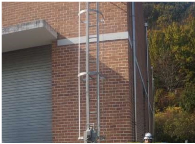
옥상층 진입사다리 상태양호 현황
