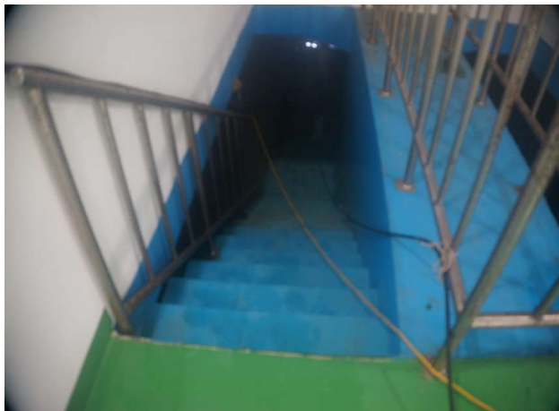
배수지 안전난간 상태 양호
