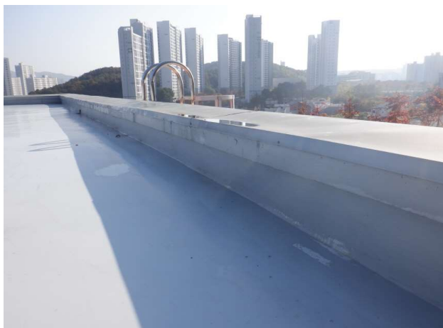
옥상 방수층, 파라펫 상태양호 현황
