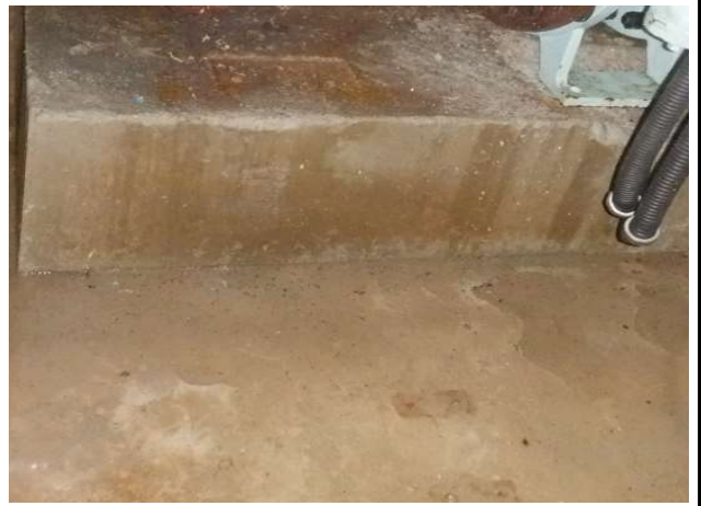
저류지 유입배관 기초베드 상태양호
