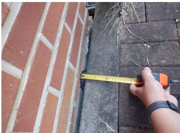
건축물 외부 바닥 이격
