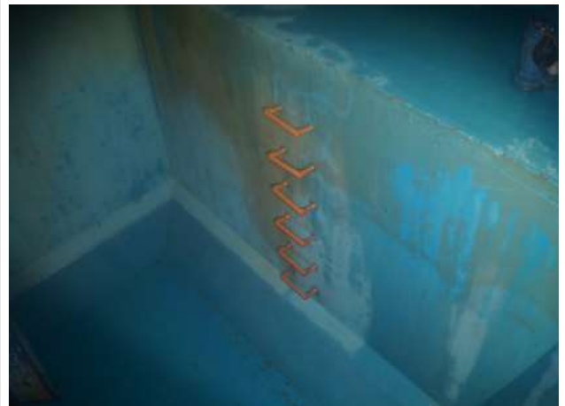
배수지 내부 사다리 상태양호
