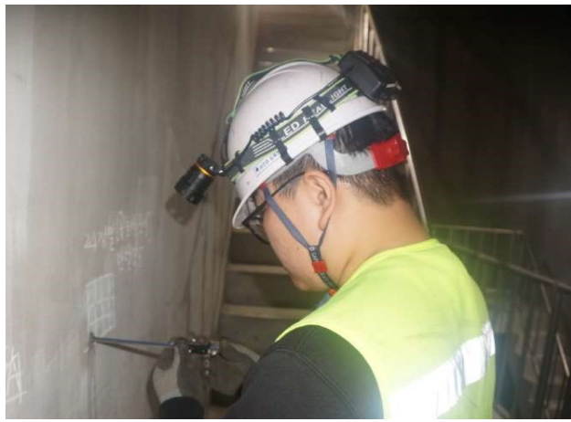
탄산화 깊이 측정
