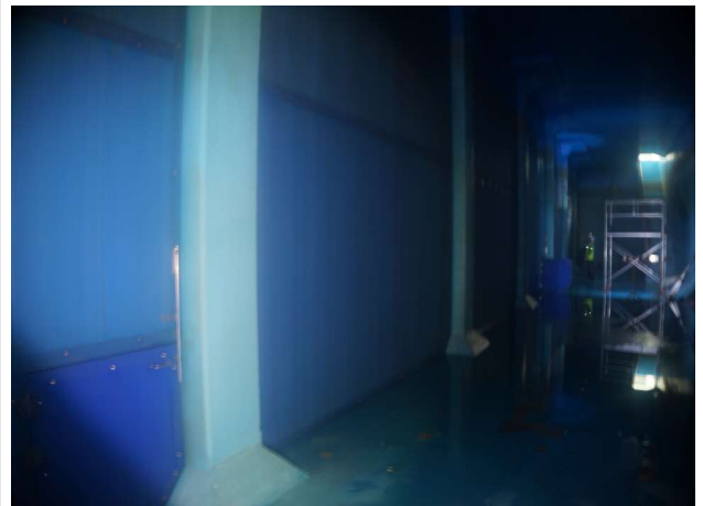
배수지2지 도류벽 상태양호
