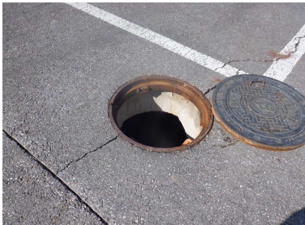
유량계실 출입구 상태양호
